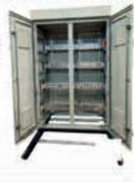
NOLL-OIL PETROLERO BITCOIN (Junction Box / Empaque de barras)
